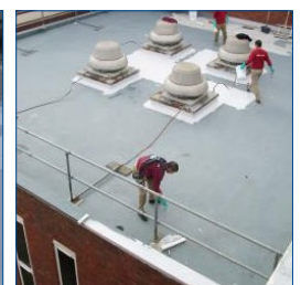
Aplicación de Belzona 3111 en proceso
