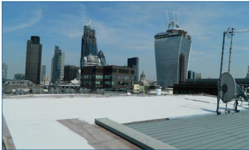
Primera capa de Belzona 3111 durante su aplicación
