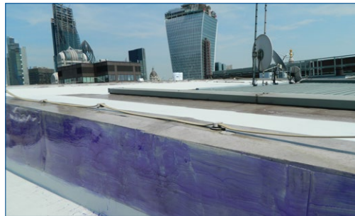
Superficie acondicionada para asegurar una buena adherencia
