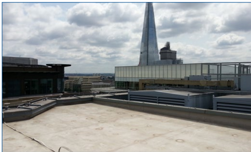
Techo limpio y preparado
