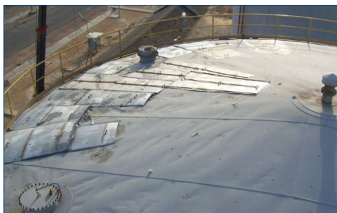
Placas soldadas con Belzona
