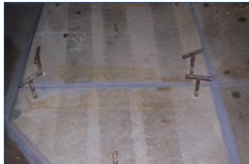
Placas soldadas sobre la plataforma
