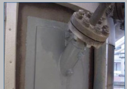
Refuerzo de placa soldada en frío
