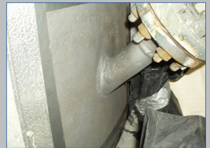
Boquilla corroída
