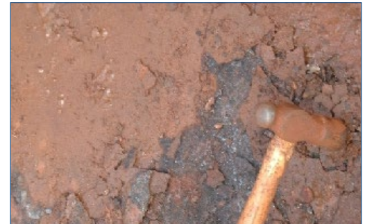
Primer plano: superficie de la plataforma corroída
