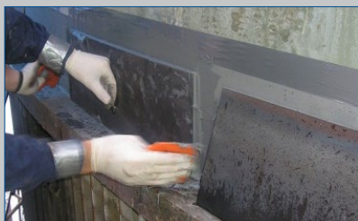
Reparación de la base de un tanque
