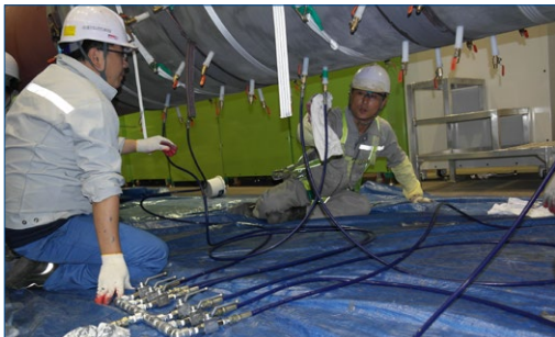
Inyección de Belzona 1321
