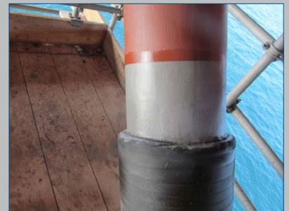
Aplicación de cuatro envolturas de Belzona 1982
