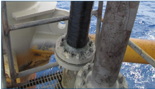
Aplicación de cuatro envolturas de Belzona 1982
