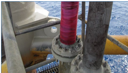
Aplicación de Belzona 9382 para consolidar la reparación
