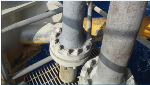
Picaduras rellenadas con Belzona 1121
