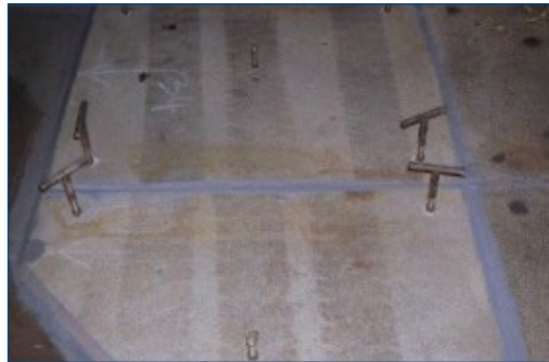
Placas soldadas sobre la plataforma
