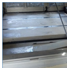
Sellado de cordones de una torre de enfriamiento
