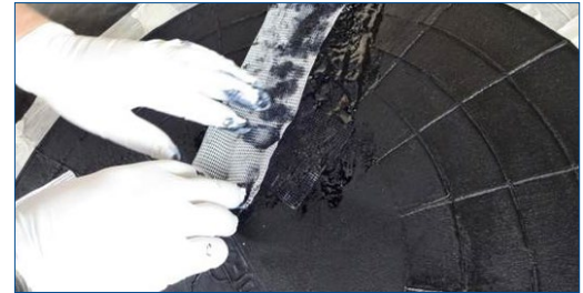
Aplicación de Belzona 9341 en Belzona 2111
