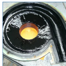
Reparaciones localizadas terminadas
