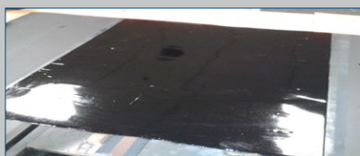
6. Capa superior de acabado aplicada
