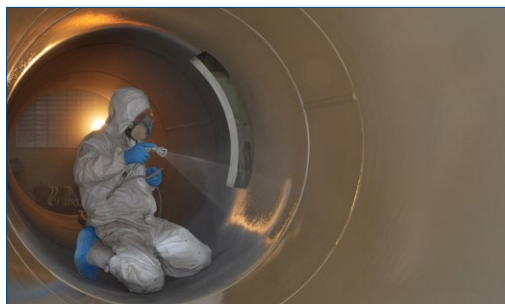
Revestimiento de Belzona aplicado con pulverizador
