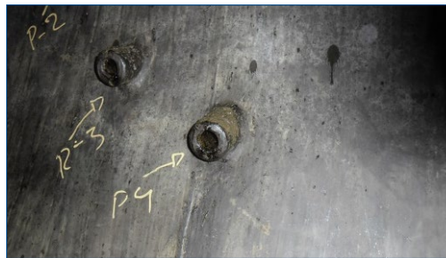
Inspección en 2013, sin defectos
