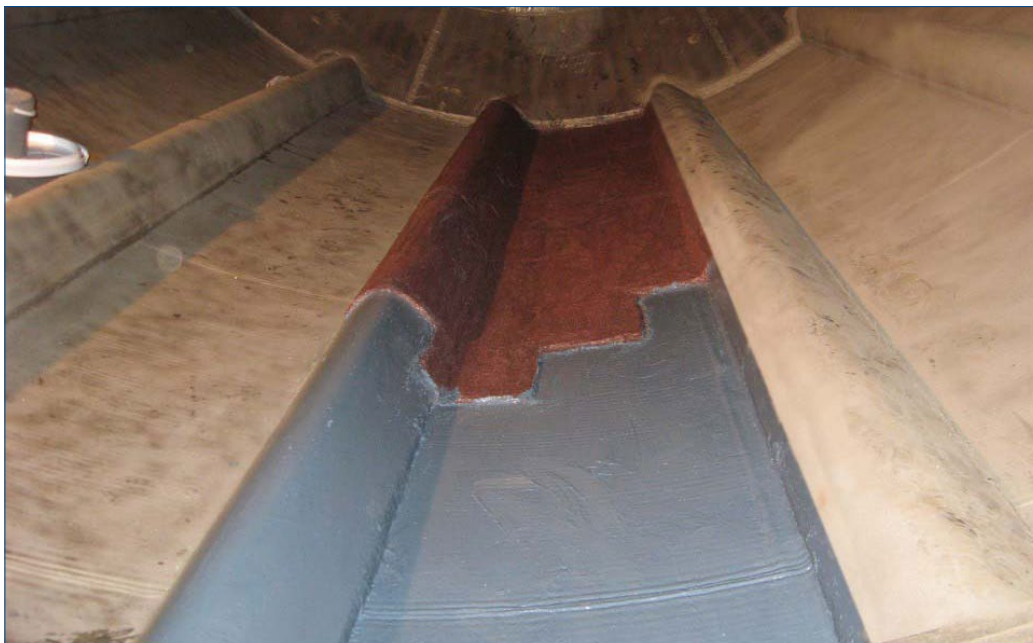
Aplicación de Belzona 1321 (en gris) y Belzona 1811 (en rojo)
