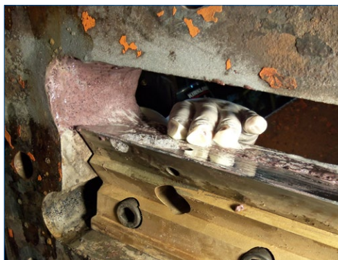
Portacuchillas del disco de la troceadora reconstruido con Belzona
