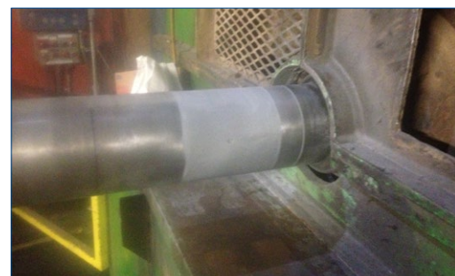
Reparación del eje en el disco de la trocadora
