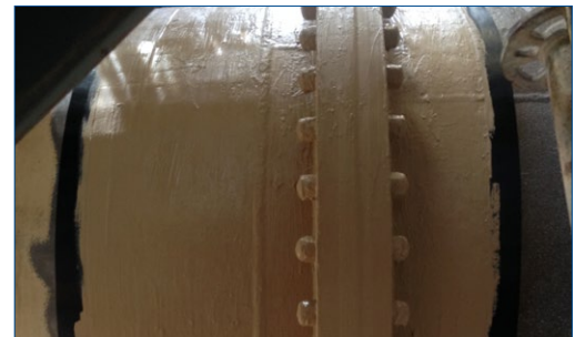
Primera capa de Belzona 3411 aplicada
