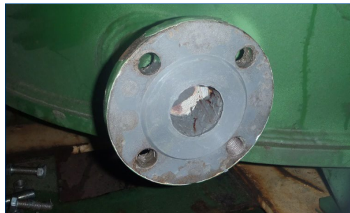
Moldeo de la cara de la brida finalizado
