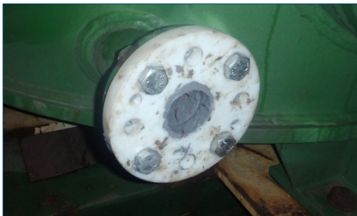
Molde colocado con material de Belzona
