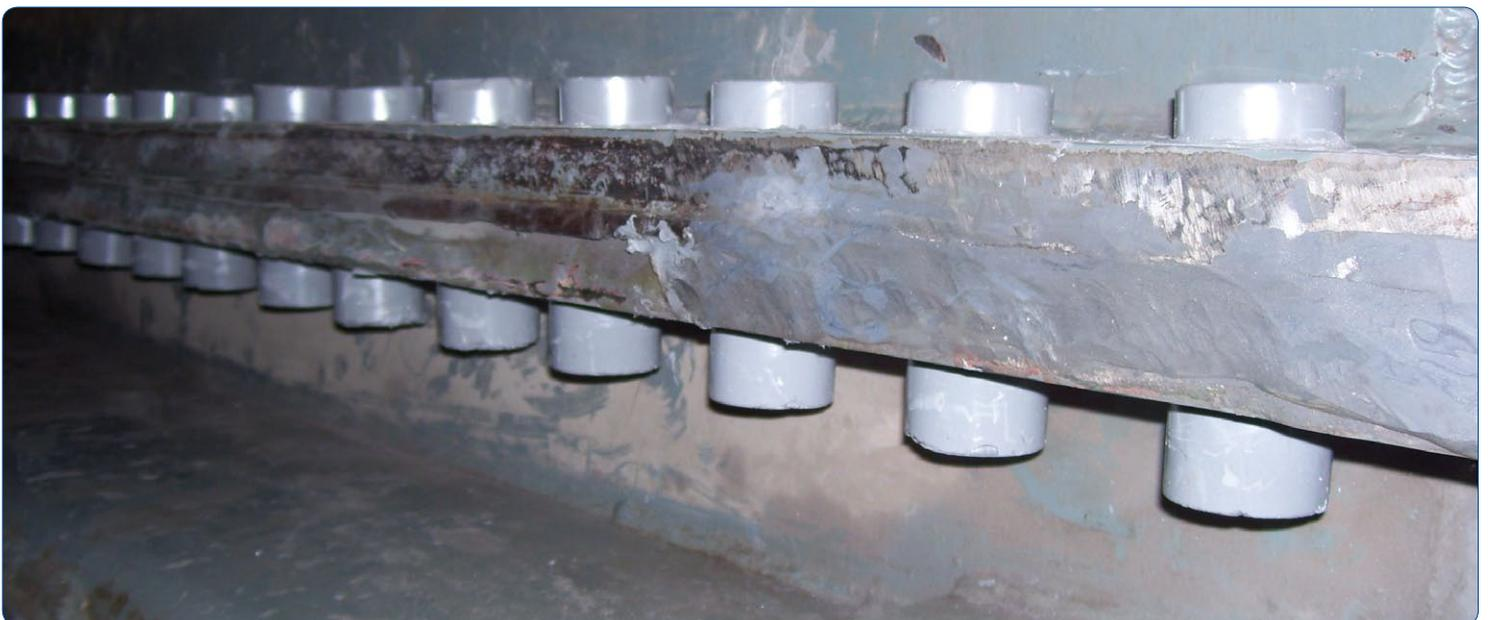
rellenaron estas secciones de tubería con Belzona 1831 (Super UW-Metal) utilizando una brocha con las cerdas recortadas. Una vez que los pernos estuvieron recubiertos, se dejó que Belzona 1831 (Super UW-Metal) fraguara.
