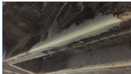
Reconstrucción de hormigón elevado
