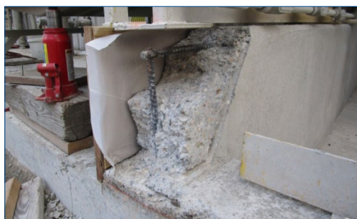
Retiro de todo el hormigón deteriorado
