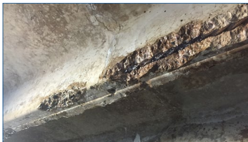
Hormigón elevado deteriorado en el estacionamiento
