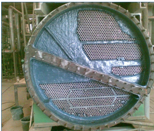
Recubrimiento de la placa de tubos finalizado
