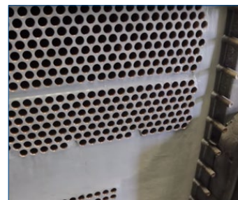
Reparación y protección finalizadas
