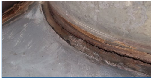
Unión deteriorada
