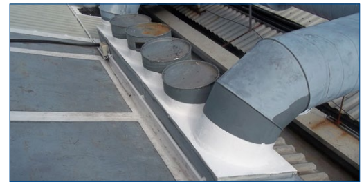
Sellado y protección finalizados
