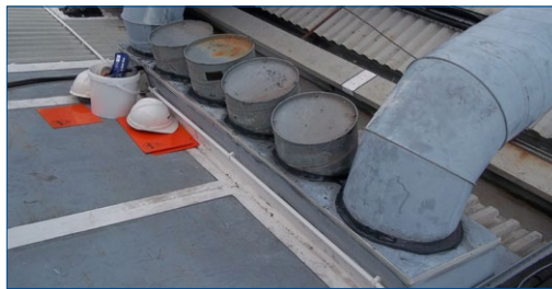
Todas las uniones selladas con Belzona 2211
