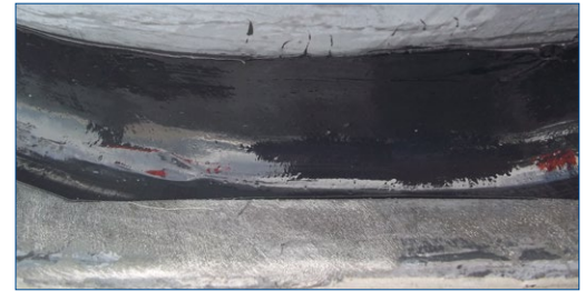
Belzona 2211 aplicado para sellar la brecha
