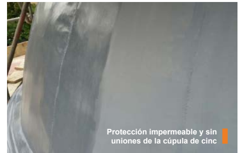
Alcance de las perforaciones en la cúpula de cinc
