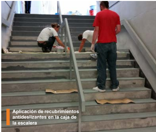
Los escalones de hormigón fueron devueltos a un sustrato nivelado
