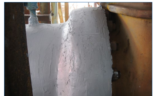
Sellado de la brida con Belzona 1161 (Super UW-Metal)
