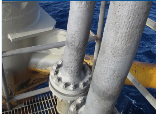
Tubería limpia después del granallado
