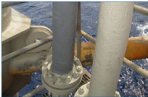
Capa superior resistente a los rayos UV aplicada
