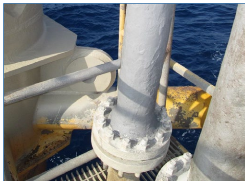
Picaduras rellenadas y espesor de la pared restaurado
