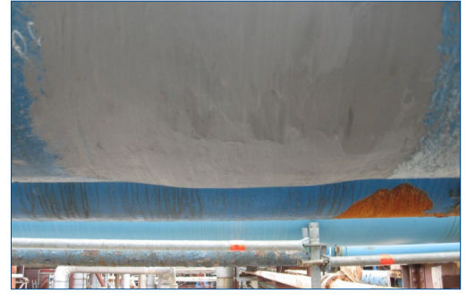
Envoltura provisoria para el área agujereada
