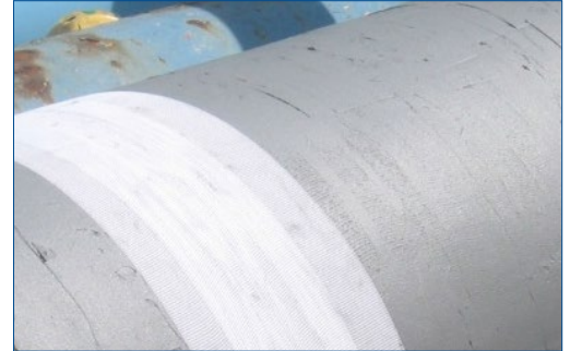
Relleno interno con Belzona 1161 (Super UW-Metal) y envoltura
