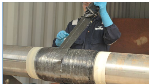
Innovación en reparaciones con compuesto SuperWrap II de Belzona
