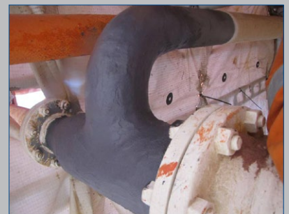
Capa superior resistente a los rayos UV aplicada
