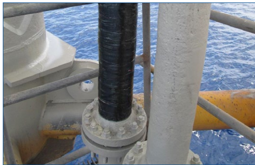
Belzona SuperWrap II aplicado
