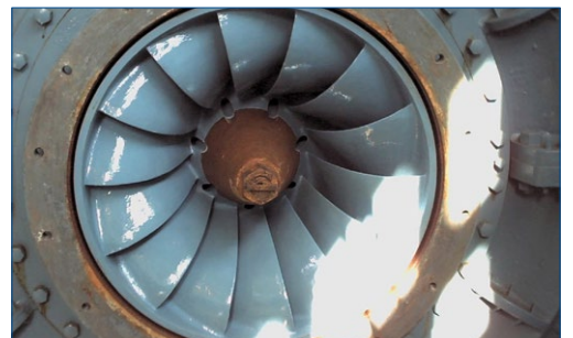
Rodete completo instalado y listo para volver al servicio
