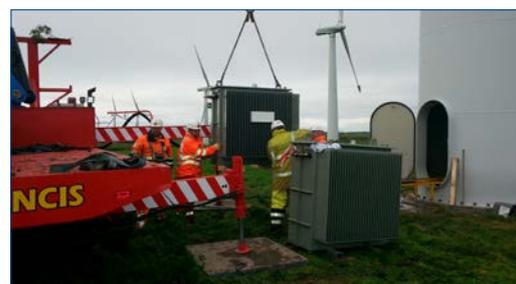
Reparación de un **transformador** con Belzona 1212
