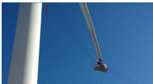
Protección de **palas** con Belzona 1341
