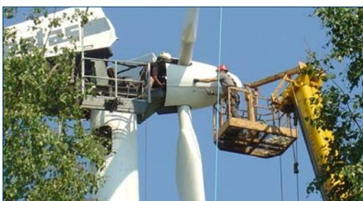
Reparación dentro de la **góndola** con Belzona 1131 (Bearing Metal)
