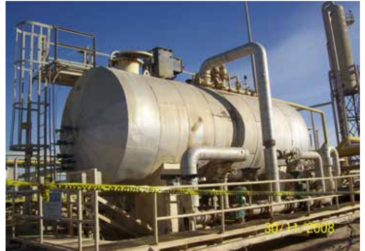
Belzona 5892 empleado para revestir un desalinizador
