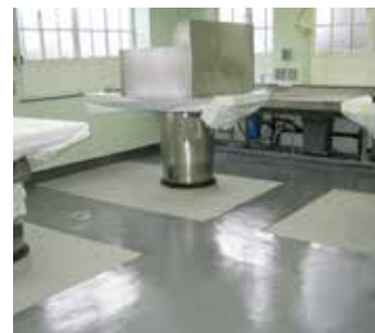
Piso de hormigón después de la aplicación
