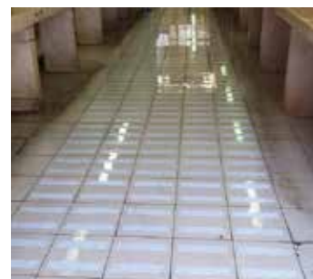
Piso de baldosas después de la aplicación
