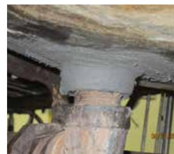
Caldera de proceso con orificios causados por corrosión en una unión de soldadura. Se aplicó Belzona 1511 en la zona afectada y se logró una reparación de larga duración.
