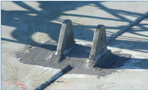
Ménsula soldada con Belzona 1111
