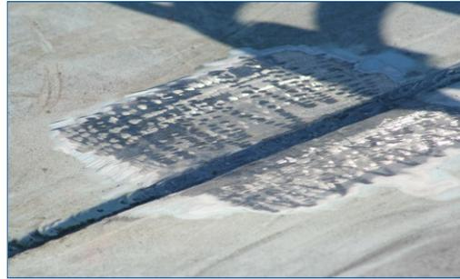
Superficie lista para la aplicación de Belzona
