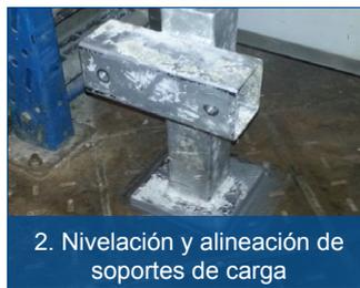
2. Nivelación y alineación de soportes de carga
