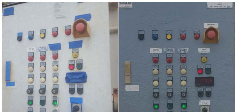
El antes y después de los paneles de control de fibra de vidrio - Acería AM/NS- Calvert, Alabama
