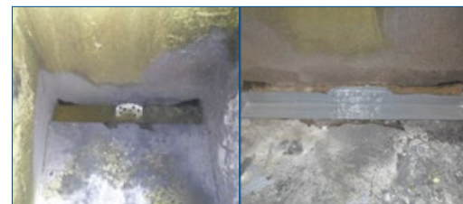
Reparación en la pared perforada de un tanque de decapado que contenía ácido clorhídrico al 36%
