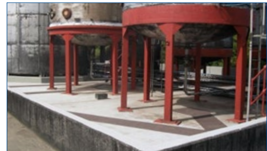
Reparaciones en el sustrato de hormigón
