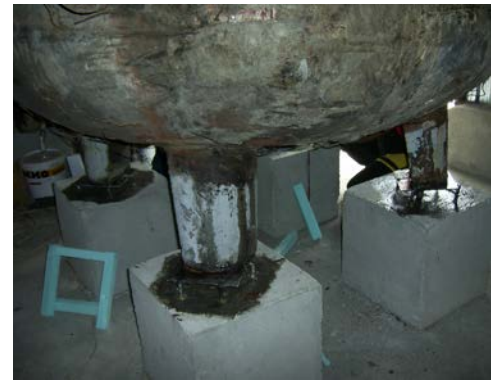
Preparación y acondicionamiento de la superficie
