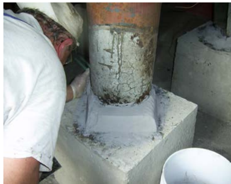
Aplicación de Belzona en acción
