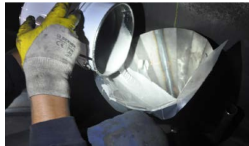
Vertido de Belzona 7111
