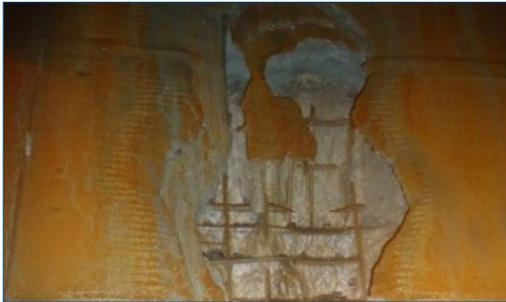
Áreas dañadas de la piletta de hormigón
