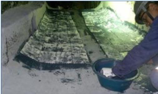
Aplicación de Belzona 9811 en un canal
